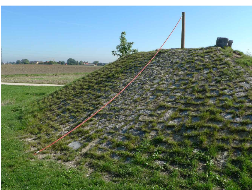
Böschungsbefestigung in Spielplätzen mit Naturstein Packlage,
